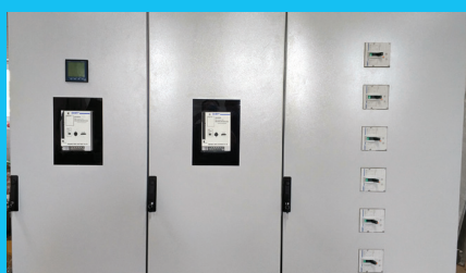
Компания ООО «Энергия»
