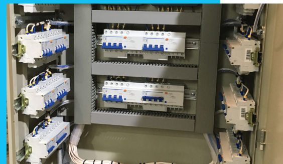
ГРЩ с АВР для административно-бытового комплекса «Роснефть» Компания ООО «Бонплет»
