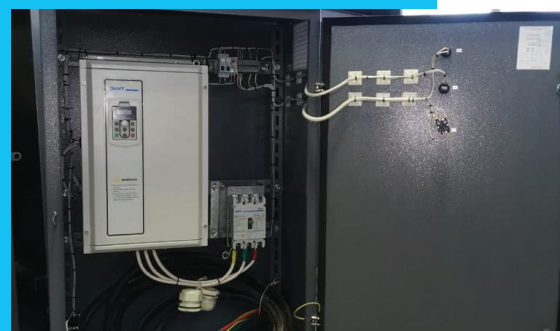
Насосная станция г. Тайшет
